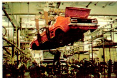
Montage von Karosserie auf das Fahrgestell
